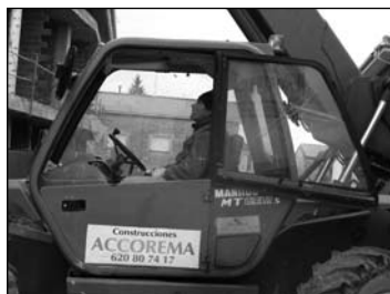
En la construcción
